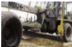
7 Eben der Tretschicht mit Lasergrader
