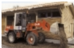
6 Aufbringen der Tretschicht mit Lader über Kopf
