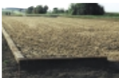
Randbefestigung mit Kunststoffschwelen
