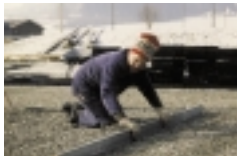
2 Verlegebett (Feinsplitt) abziehen (per Hand oder mit Grader)
